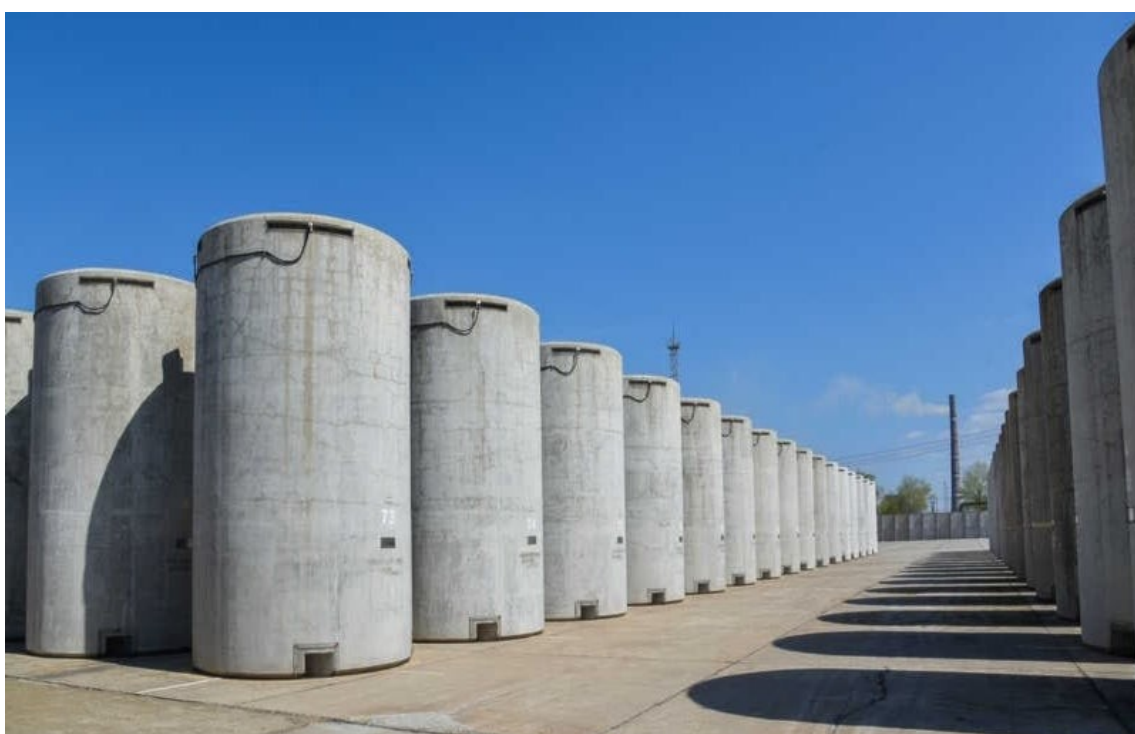
Figura 4: Contenitori in cemento (Cask) contenenti le barre esauste immagazzinate 'a secco'. Credit NNEGC Energoatom
