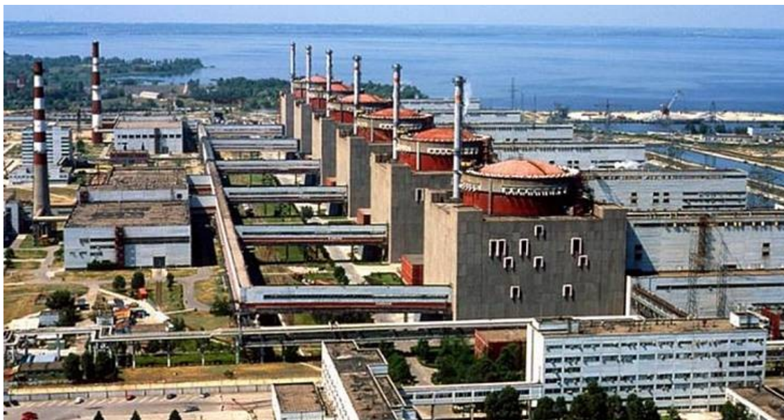
Figura 2: Veduta dei sei reattori della centrale di Zaporizhzhia. I reattori sono dei VVER-1000/320s di fabbricazione sovietica, di tipo ad acqua pressurizzata (Pressurized Water Reactor o PWR) e ognuno è in grado di generare circa 950 MW netti di elettricità. Credits Energoatom.
